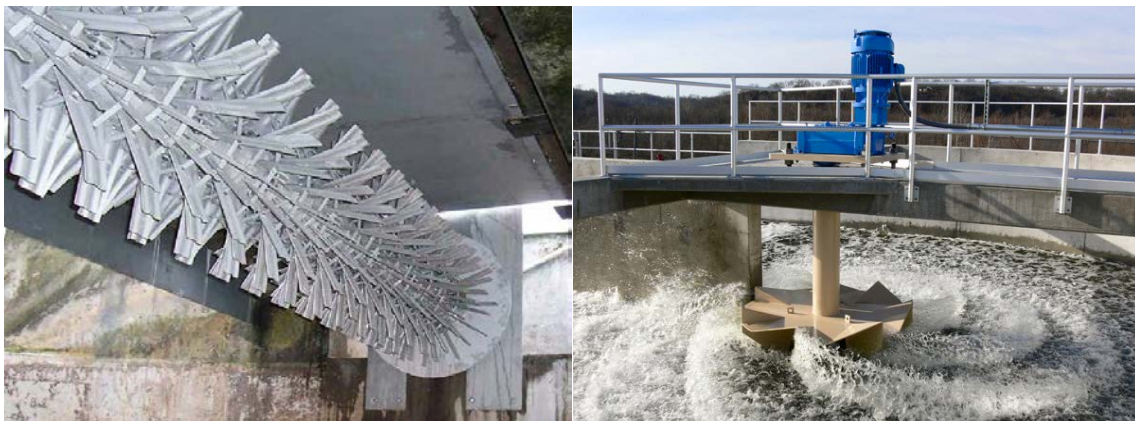
Слика 3.4: Површински аератори а) хоризонтален[29], б) вертикален[30]
