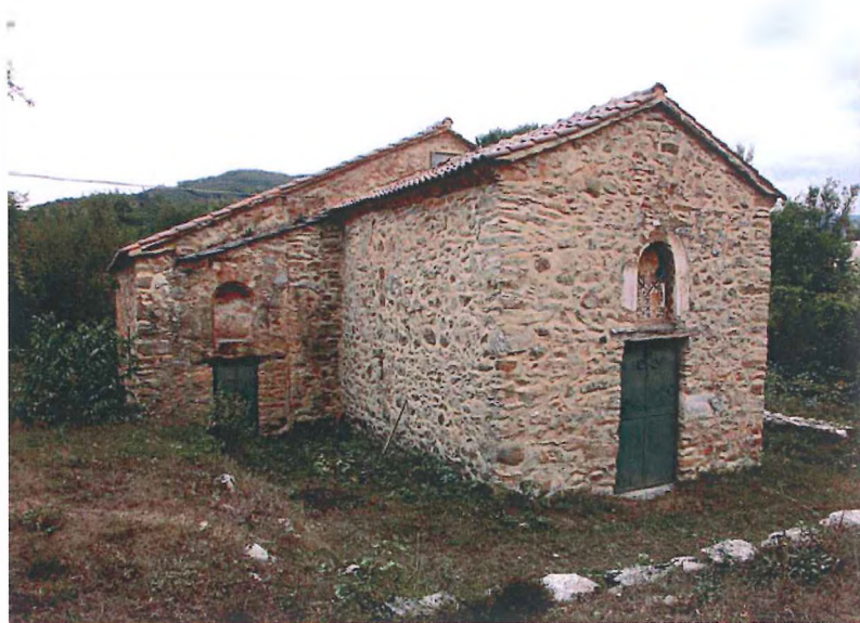
Сл. 10 Црквата Св. Никола Топлички, северозападна страна
